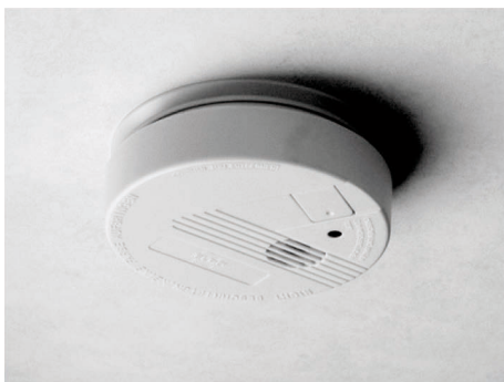
Fig. 43: Rivelatore di fumo
