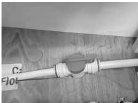
Fig. 93: valvola riscaldamento a pavimento ALDE
