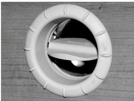
Fig. 136: Bocchetta dell'aria calda aperta
