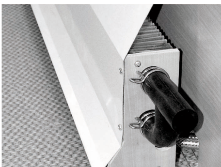
Fig. 91: Convettore con deflettore del calore in lamiera
