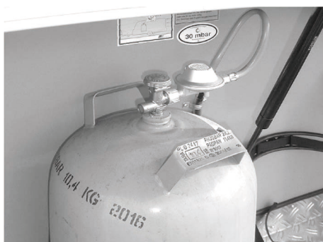
Fig. 77: Valvola riduttrice di pressione
