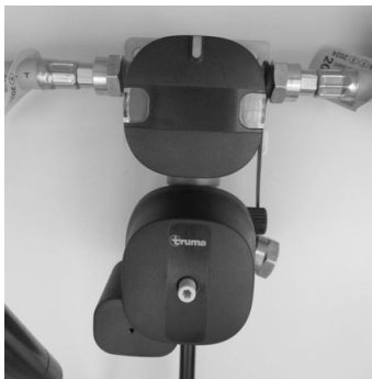
Fig. 116: Alimentazione del gas DuoControl CS
