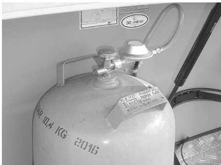
Fig. 115: Bombola di gas con valvola riduttrice di pressione
