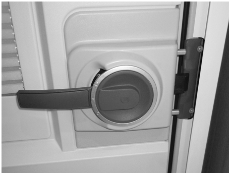
Kuva 20: Oven lukko suljettu, mutta ei varmistettu
