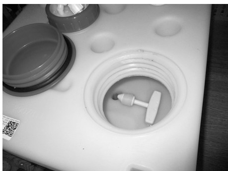
Kuva 95: Tyhjennystulppa raikasvesisäiliössä
