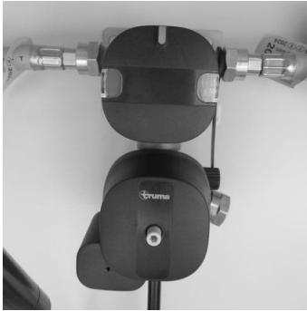
Kuva 83: Kaasusyöttö (Eis-Ex:llä ja kaukonäytöllä)
