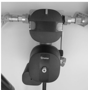
Kuva 109: Kaasusyöttö DuoControl CS
