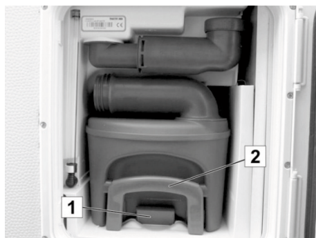
Bild 154: Fekalietank i avfallsschaktet
