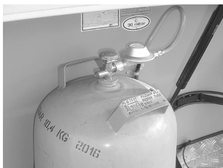
Bild 107: Gasolflaska med tryckreducerventil
