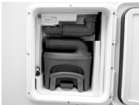
Bild 57: Fekalietank med påfyllningsstuts för spolvatten
