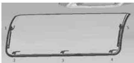
Bild 37: Vy invändigt av välvt utåt öppningsbart fönster med fem låsvred
