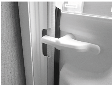
Bild 28: Dörr delad, låsanordningen låst
