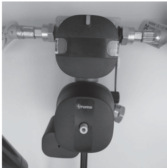
Kuva 116: Kaasusyöttö DuoControl CS
