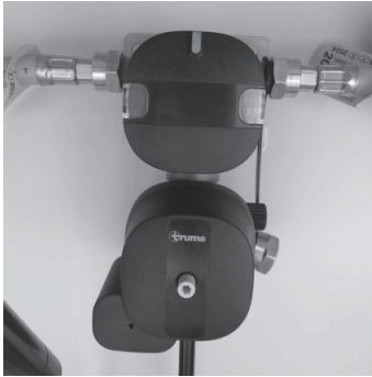
Kuva 78: Kaasusyöttö (Eis-Ex:llä ja kaukonäytöllä)
