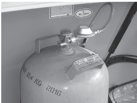
Kuva 115: Kaasupullo ja paineenalennusventtiili
