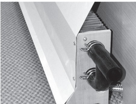
Kuva 91: Konvektori ja lämmönjohtopelti
